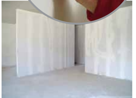
Resultado final de los paneles Aircrete
